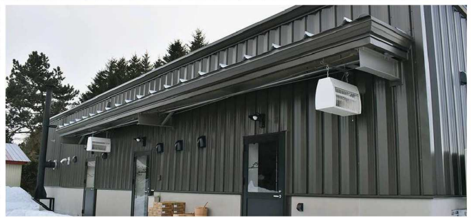
竣工した新施設の外観
