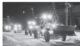
<市道除雪の様子>
