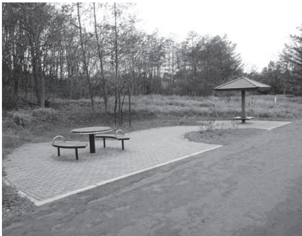
園路・休憩施設の整備
