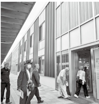
▲新得駅前地域交流センターとくとく 外観
