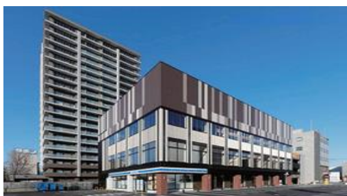
分譲マンションや商業施設等の整備 「西3・9周辺地区第一種市街地再開発事業」
