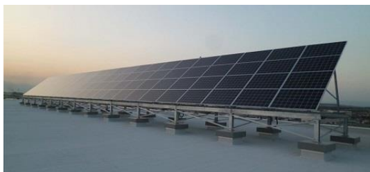
公共施設への太陽光パネルの設置
