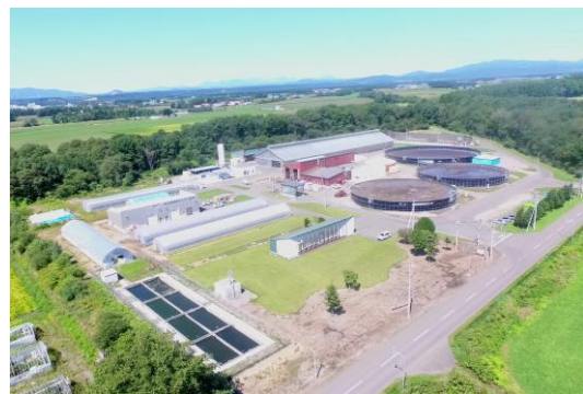
バイオガスのプラント
