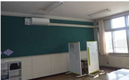
エアコン設置の様子
