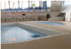
プールサイド床面の工事
