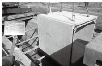
雨水管の整備
