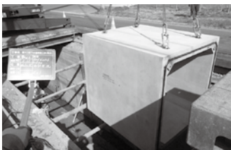
雨水管の整備
