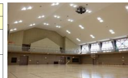
特定天井対策・照明LED化改修工事
