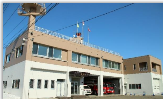
【中札内消防署 令和3年3月増改築】
