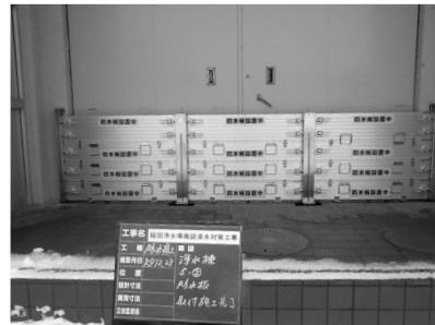
浸水対策として 稲田浄水場に止水板を設置
