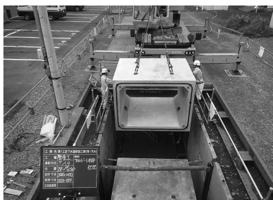
雨水管の整備
