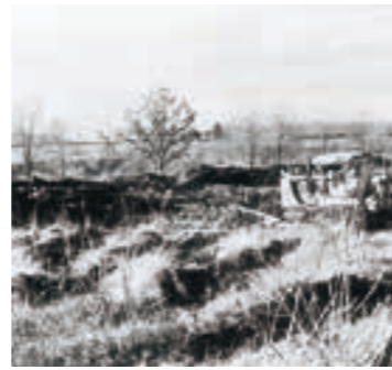
開園前の整地作業
