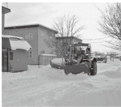
**A** 降り積もった路面の雪(新雪)を道路脇に振り分け、通行可能なスペースを確保する作業を「新雪除雪」といいます。
