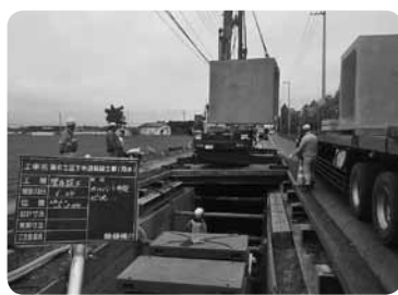
雨水管の整備
