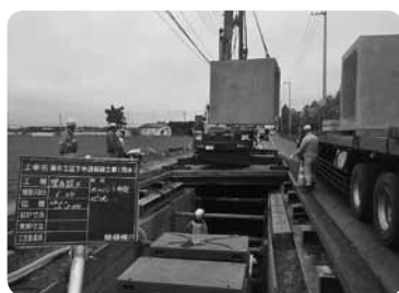
雨水管の整備
