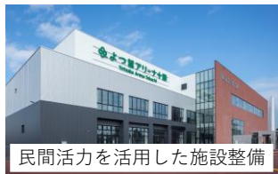
帯広市総合体育館
