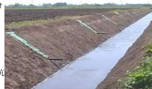
かんがい排水施設の整備の様子
