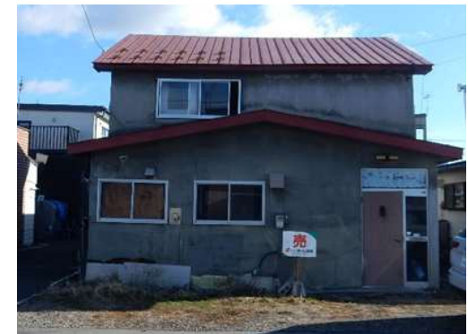
解体につながった特定空家
