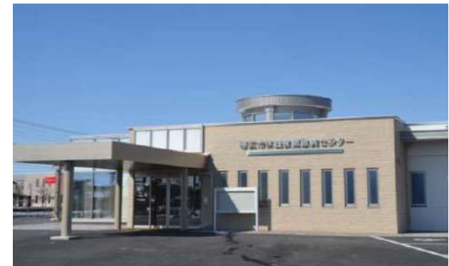
帯広市休日夜間急病センター
