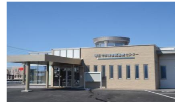
帯広市休日夜間急病センター
