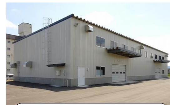
令和4年3月に完成した拠点備蓄倉庫
