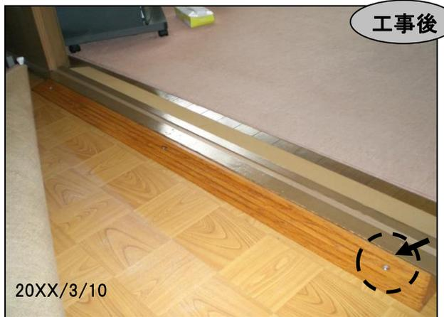
写真のように必ず、固定されていなければなりません。固定の方法は、ビス留め、貼り付けでも可です。固定されていない場合は、改修費支給対象とはなりません。
