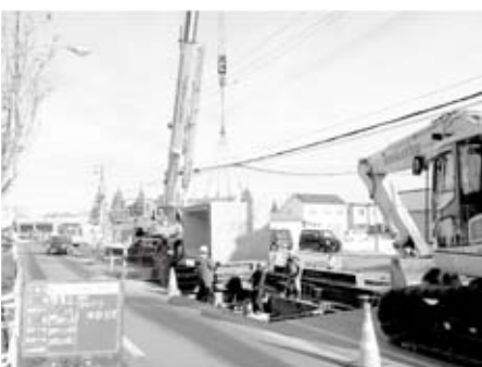
雨水管の整備
