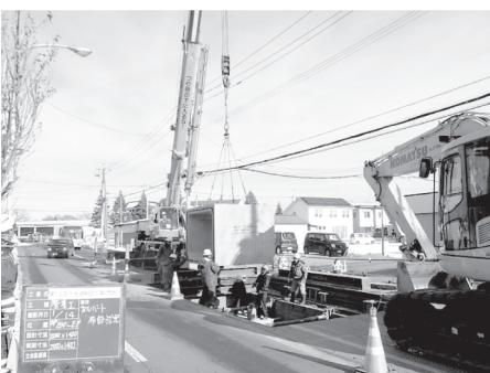
雨水管の整備
