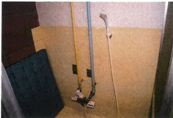
実習館 シャワー室
