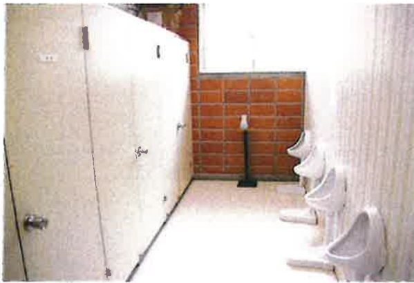
実習館 トイレ
