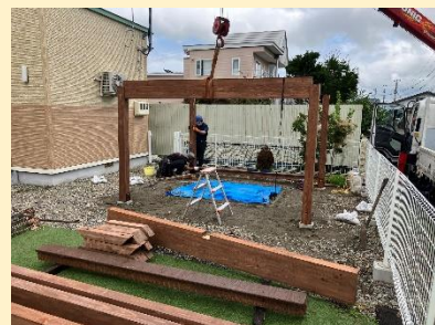
設置工事の様子
