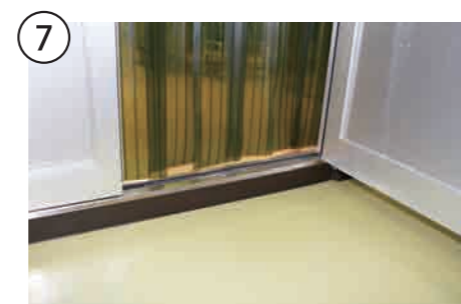
7 清潔区に通じるドアは、埃や異物が入らないようわざと段差を設けてある。
