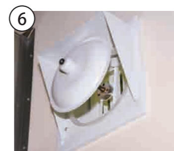
6 製造室は異物が入り込まないよう加圧されている。
