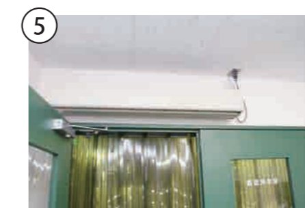
5 虫の侵入は防虫カーテンとエアーカーテンの2重で防いでいる。
