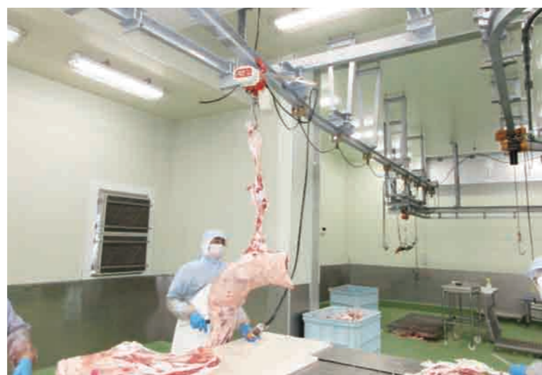
まな板のところまで移動クレーンの動線を延長
