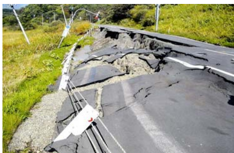
平成15年十勝沖地震（豊頃町）
