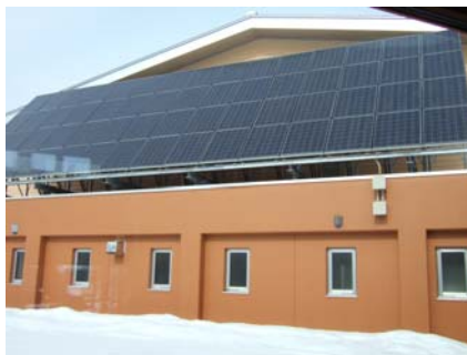
公共施設への太陽光パネルの設置
