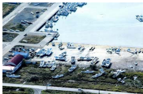
平成15年十勝沖地震（豊頃町）
