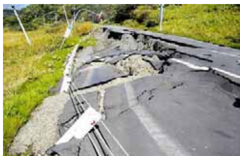
平成 15 年十勝沖地震 (豊頃町)
