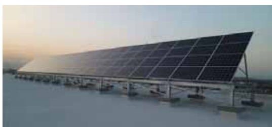
公共施設への太陽光パネルの設置
