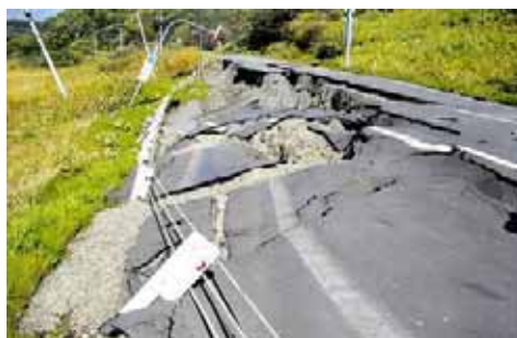
平成 15 年十勝沖地震 (豊頃町)
