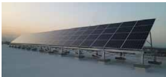
公共施設への太陽光パネルの設置
