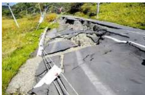
平成 15 年十勝沖地震 (豊頃町)
