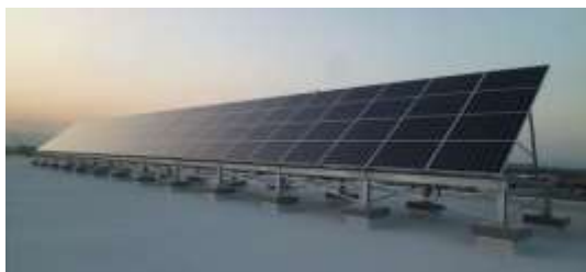
公共施設への太陽光パネルの設置
