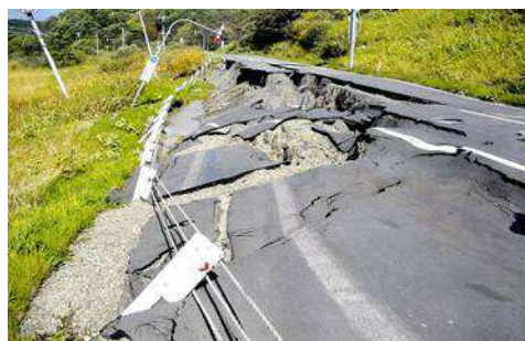
平成 15 年十勝沖地震 (豊頃町)
