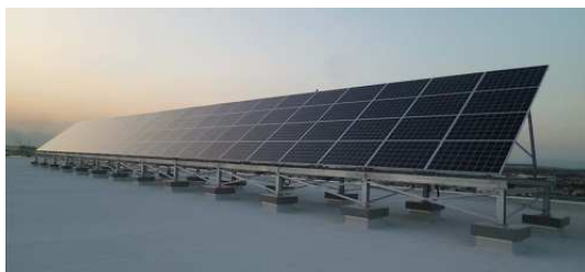
公共施設への太陽光パネルの設置
