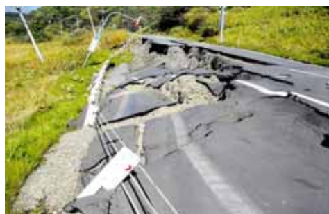
平成15年十勝沖地震(豊頃町)
