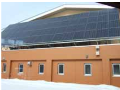
公共施設への太陽光パネルの設置
