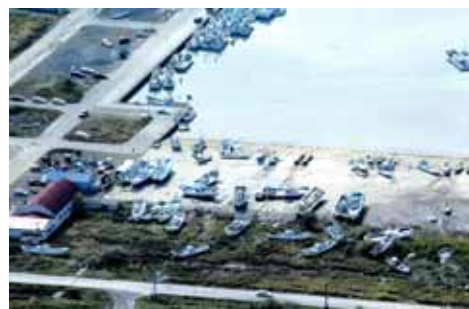
平成15年十勝沖地震(豊頃町)
