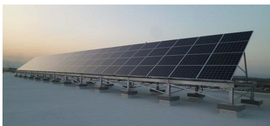
公共施設への太陽光パネルの設置
