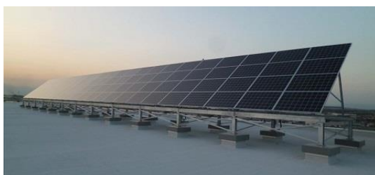
公共施設への太陽光パネルの設置
