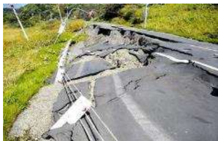
平成 15 年十勝沖地震（豊頃町）
