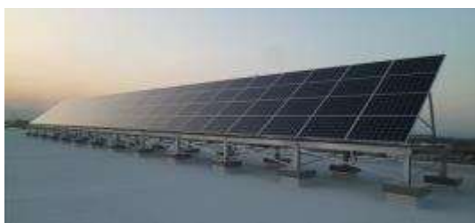
公共施設への太陽光パネルの設置
