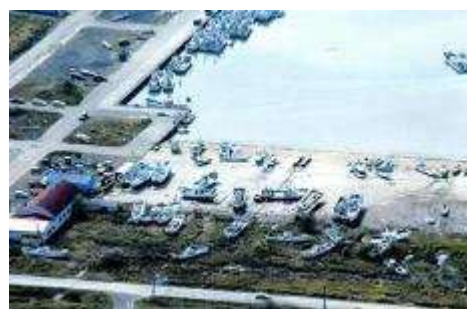
平成 15 年十勝沖地震（豊頃町）
