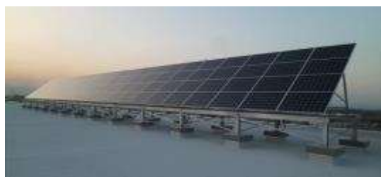
公共施設への太陽光パネルの設置
