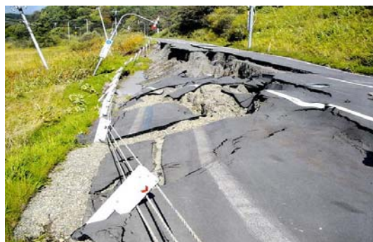
平成15年十勝沖地震（豊頃町）
