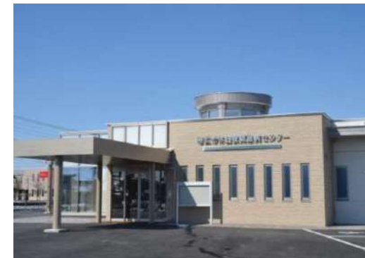
帯広市休日夜間急病センター
