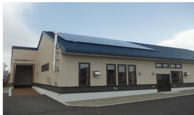
太陽光発電システム（帯広市清流の里福祉センター）
