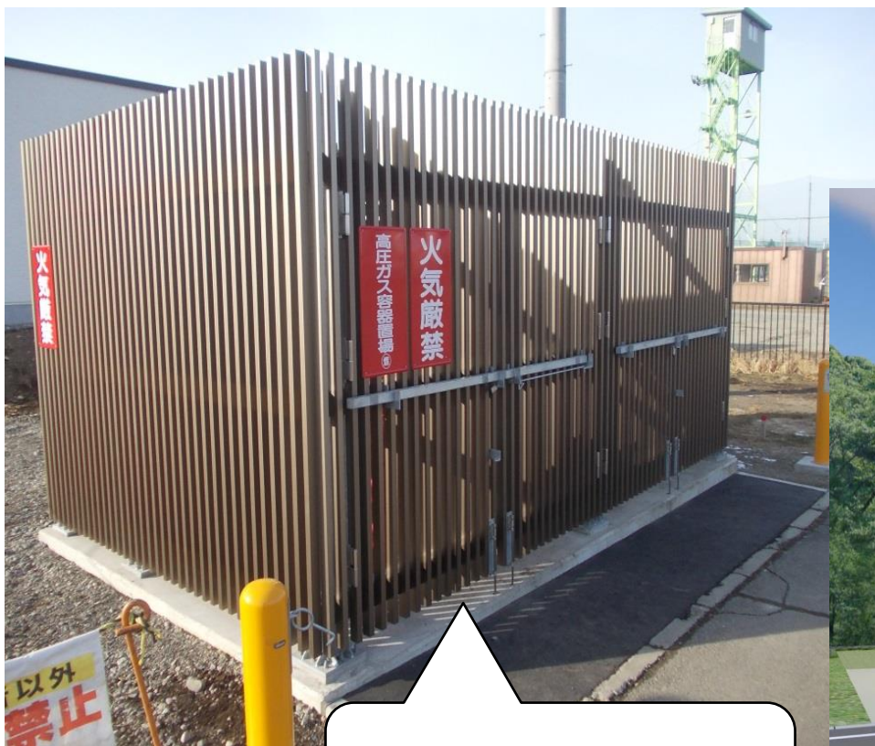
水素ポンベカードル
