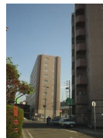
JR帯広駅の北側に立地した借上げ市営住宅（奥側）と賃貸マンション
