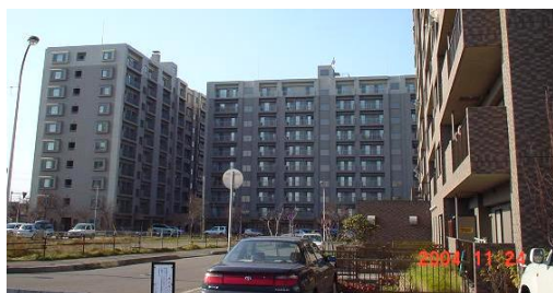
JR帯広駅の南側に立地した分譲マンション群
