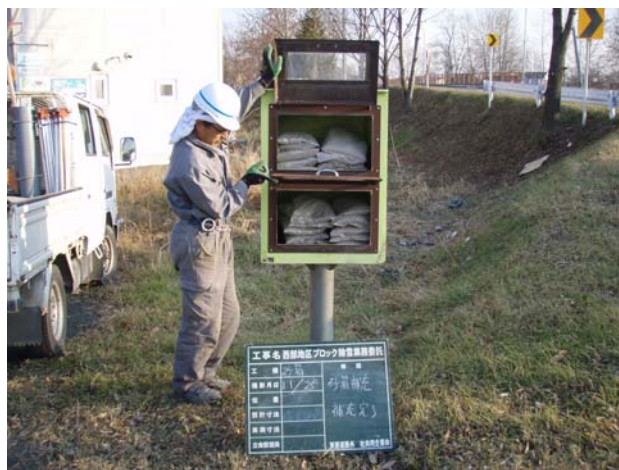
※砂箱に砂を補充している状況
