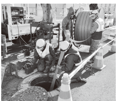
下水道管（老朽管）の更新
