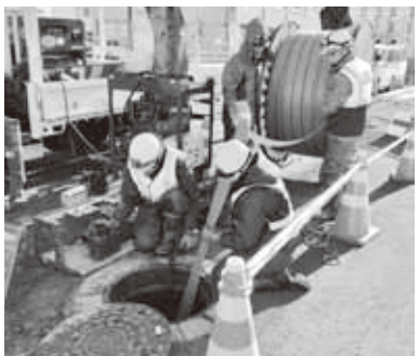
下水道管（老朽管）の更新
