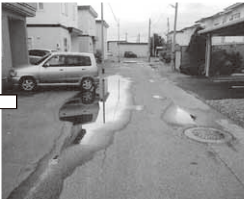
雨水管と雨水ます整備前
