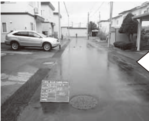
雨水管と雨水ます整備後
