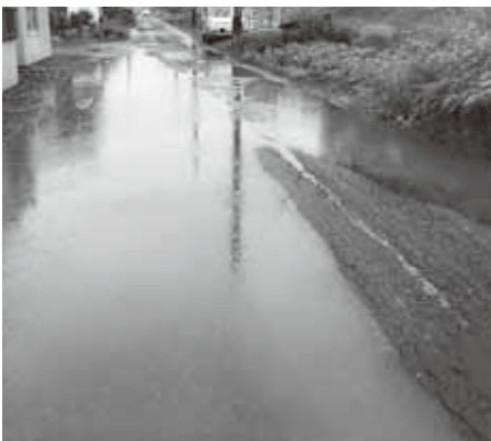
冠水した市内道路
