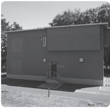
稲田浄水場設備機器の更新
