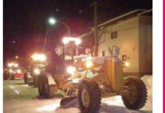
冬の交通を確保するため、市道の除雪作業を行います。
